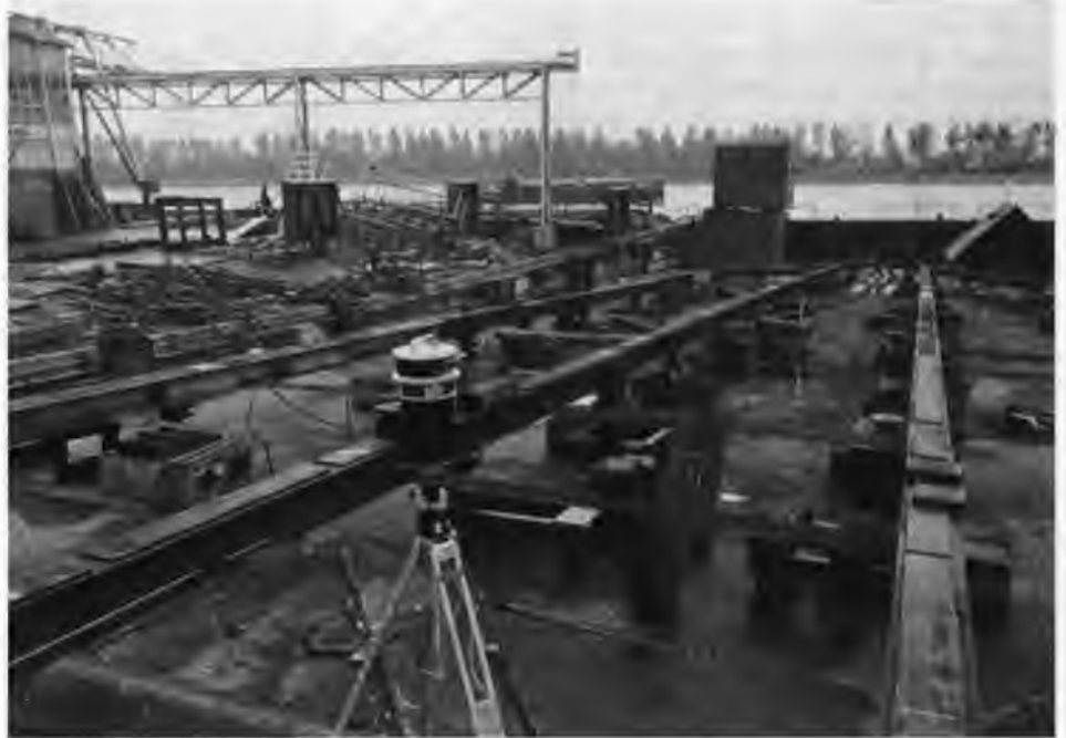
figuur 21: het op hoogte brengen van een blokkenbed
