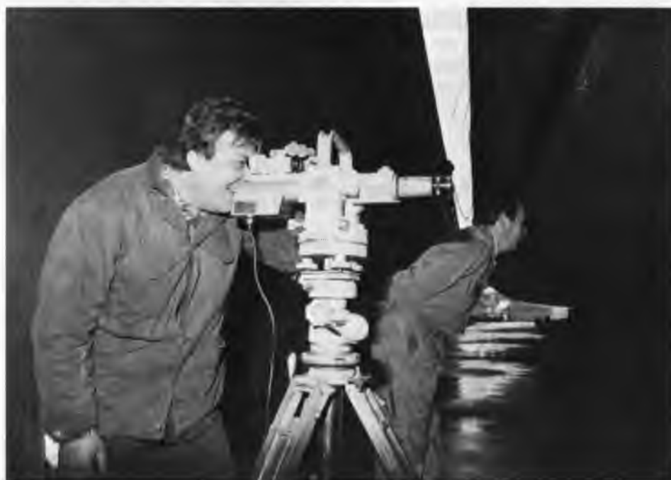
Figuur 1: het meten van de onderzijde van het schip met een z.g. universele bouwlasers
