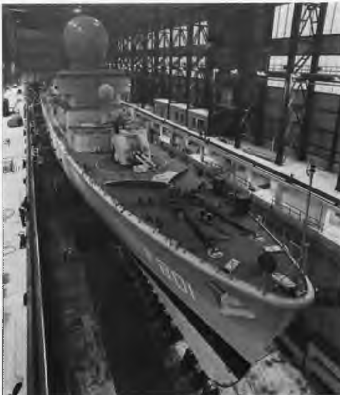
Foto 3. Het overdekte dok van de Rijkswerf te Den Helder, qua afmetingen geschikt voor alle schepen der Kon. Marine tot en met de G. W. fregatten.
