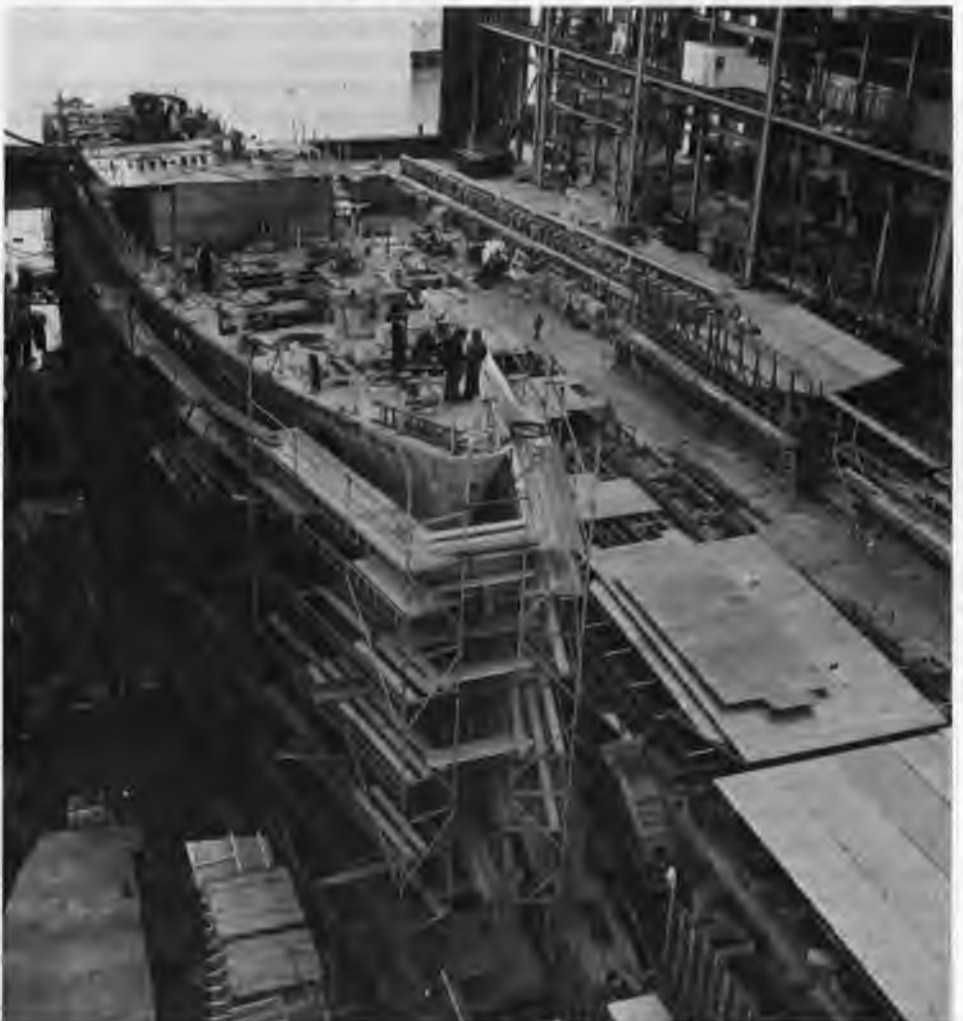
Foto 5. De bouwloods van de Yarrow yard in Glasgow, Schotland met een fregat voor de marine van Thailand op de ene helling. Op de tweede helling ligt de kiel voor een zgn. Type 21 Frigate voor de Royal Navy. De derde helling is nog leeg.
