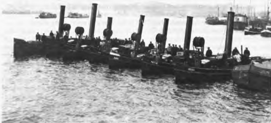
Een der vele illustraties: een serie zogenaamde waterboten van particuliere eigenaars. Deze werden door de gemeentelijke drinkwaterleiding gehuurd voor de levering van helder water aan de schepen in de havens. Duidelijk zijn de slangenhaspels op het voordek te zien.
